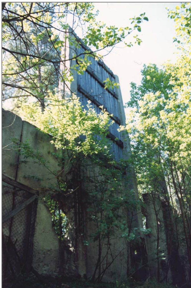
A. Przestrzeń pomiędzy 12-metrowymi filarami była wypełniona drewnianymi ramami. Fot. L. Walkiewicz
